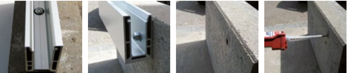
Монтаж системы GF ЛК60
